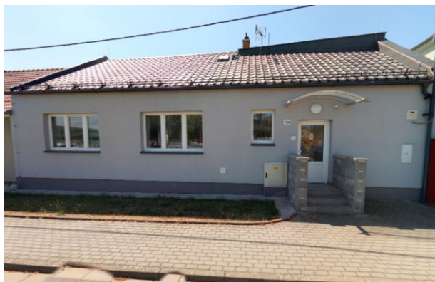
Obr. 30 Stavba občanského vybavení
